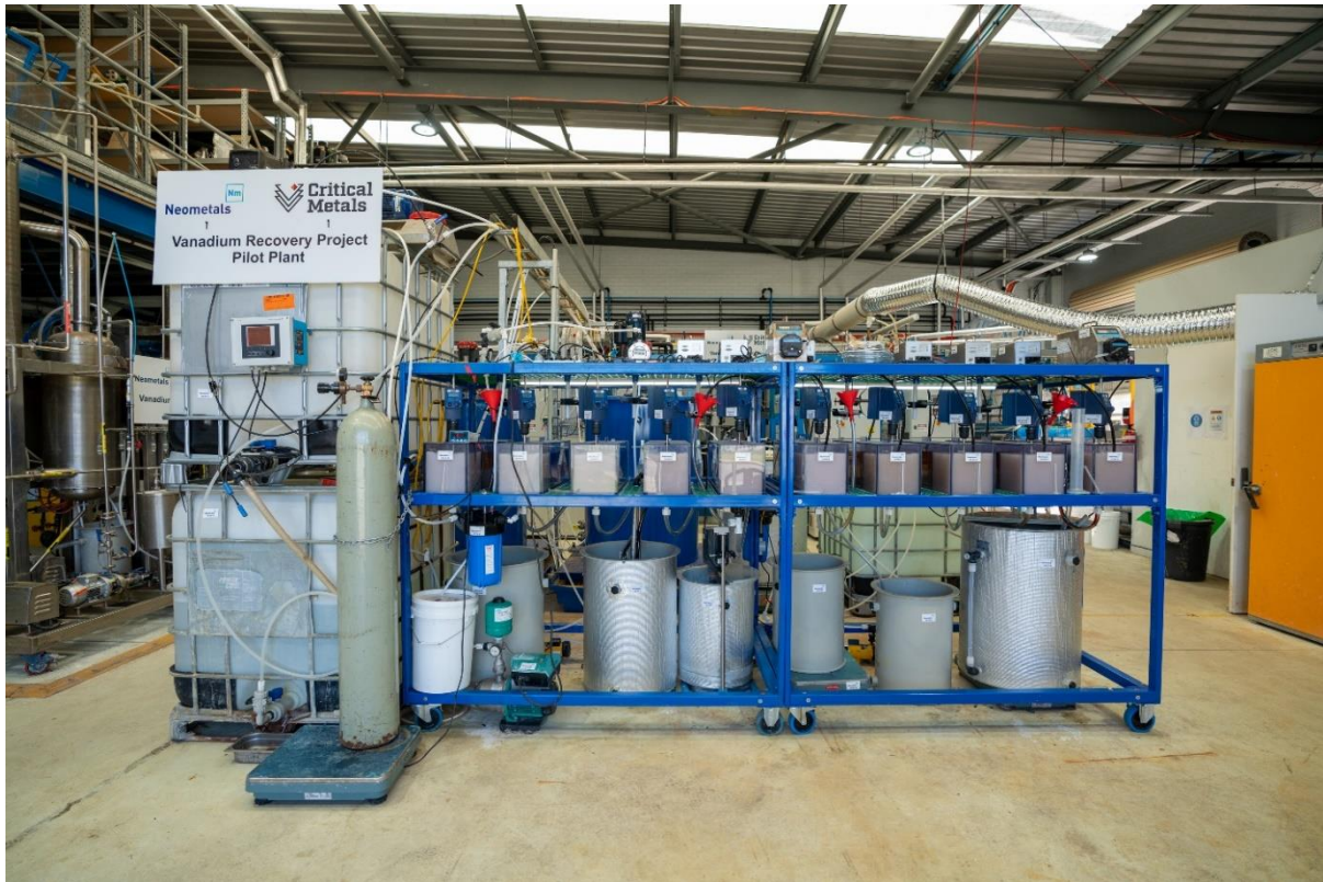
Abbildung 2 - Bereich für die Lösungsmittelextraktion der Pilotanlage
